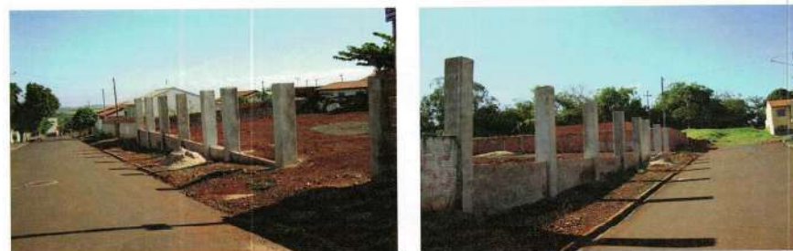
Início das fundações da futura igreja, em 2010
