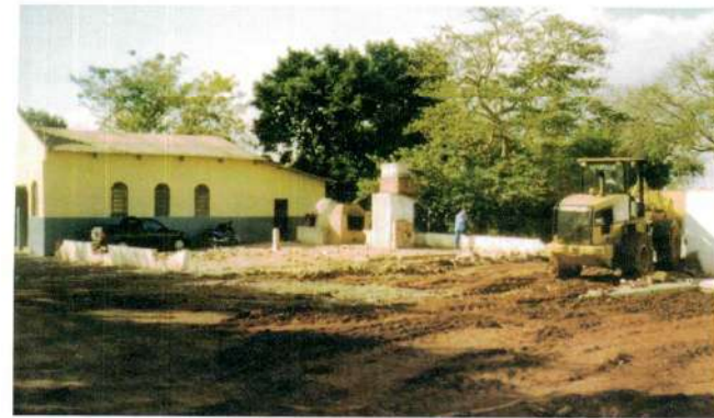
Construção do salão em 2005
