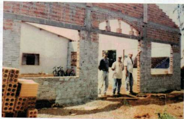
Aqui a construção já com cara de igreja - 1997
