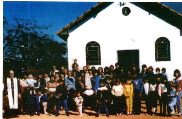
A capela de alvenaria, concluída em 1979
