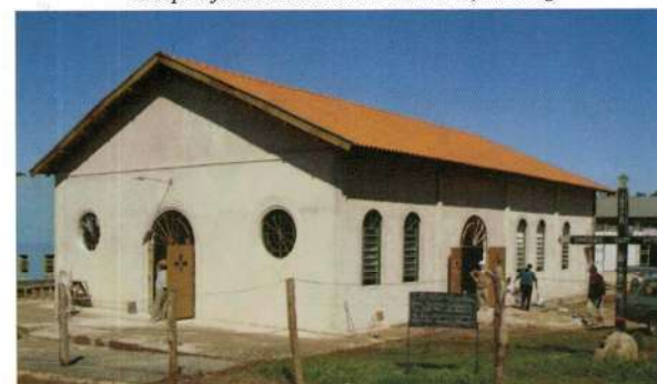
A igreja em fase final de construção: 2005
