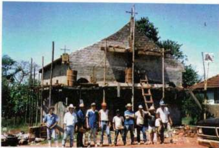
Construção da capela, com voluntários de Jataizinho 1992
