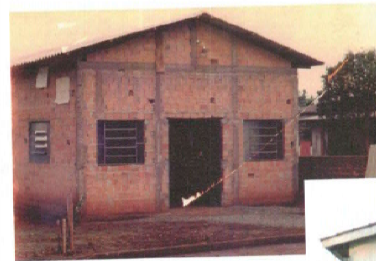
Salão de catequese foi a primeira construção, em 1995
