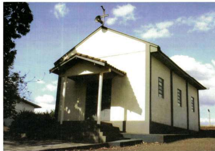
Prédio da capela atual é de 1984
