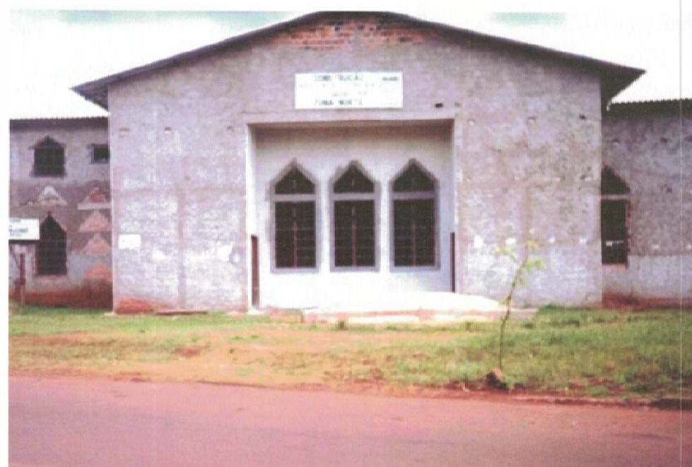
A igreja coberta aqui já com as janelas desenhadas por Henrique Aragão
