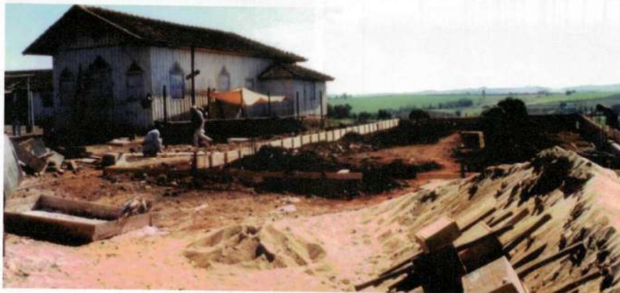
Começa a construção da igreja de alvenaria – 1994
