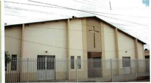
Após a ampliação, capela e salão ficaram sob a mesma cobertura
