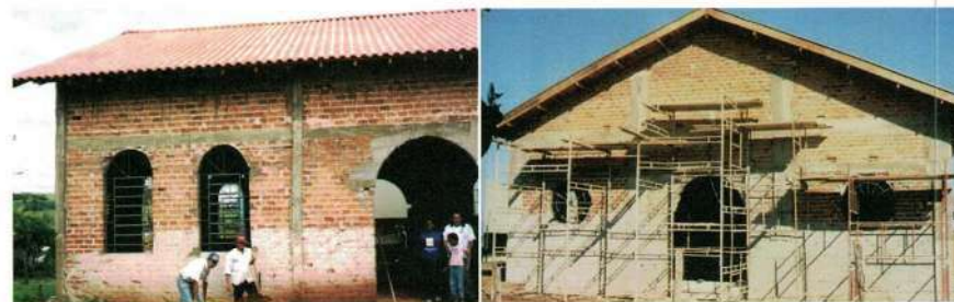
A capela já coberta e iniciando o reboco, em 2005
